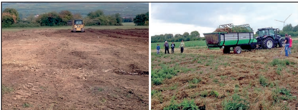
Abb. 4: Links: Heller, kalksteinreicher Skelettboden tritt nach Abschieben des nährstoffreichen Oberbodens (dunkel, rechts oben im Bild) zutage. Rechts: Mittels Traktor wird das Mahdgut von den Spenderflächen geholt und anschließend händisch verteilt (Fotos: Daniel STEFFEN 2018).
